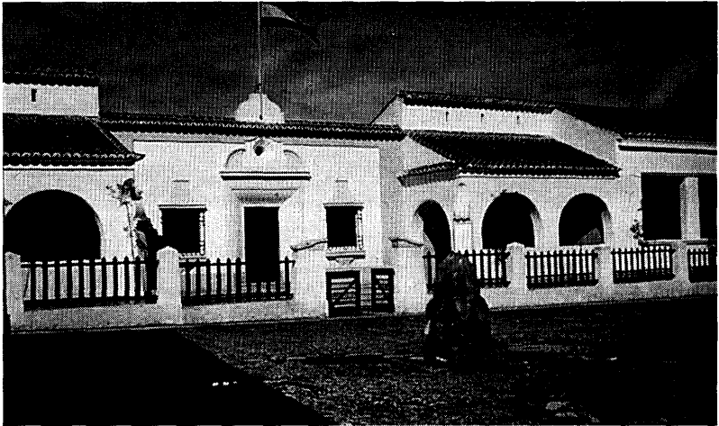
A.G.A. Grupo de Fondos de Obras Públicas. D. G. de Regiones Devastadas. Escuelas de Alcaracejos, Córdoba.
